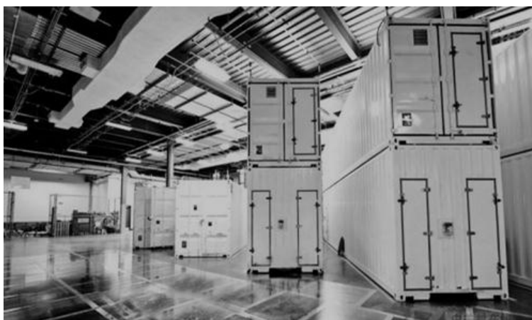
图4-2 微软集装箱式数据中心
